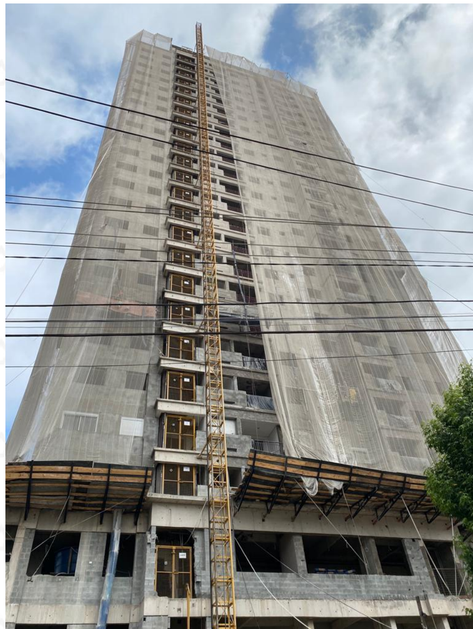
Estágio atual de obra (56,77%)
