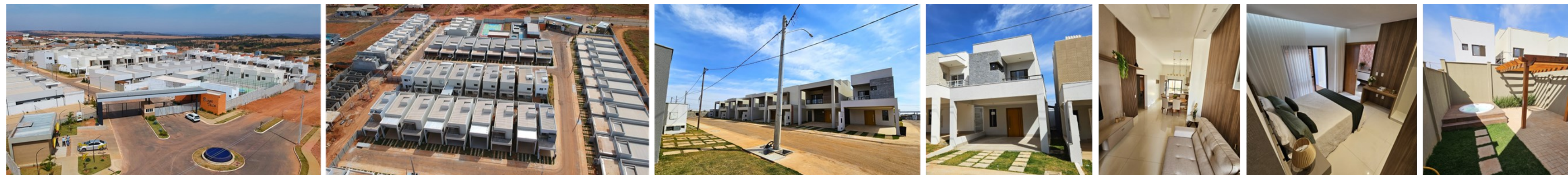
Empreendimento Villagio Buena Vista – Visita técnica em Catalão – GO no dia 29 de julho de 2023
