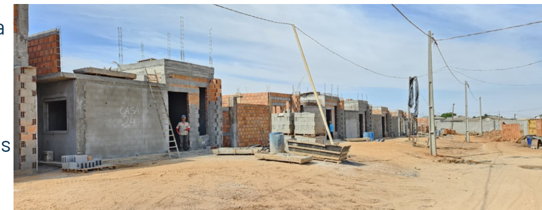
Empreendimento Villaggio Buena Vista, segunda etapa – Visita Técnica HGI 29/07/2023
