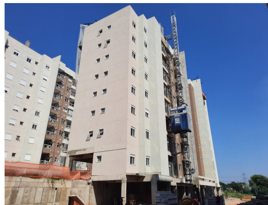
Torre 4 - Yes Jundiaí - Medição de obra Monitori 12/23 (82,34%)
