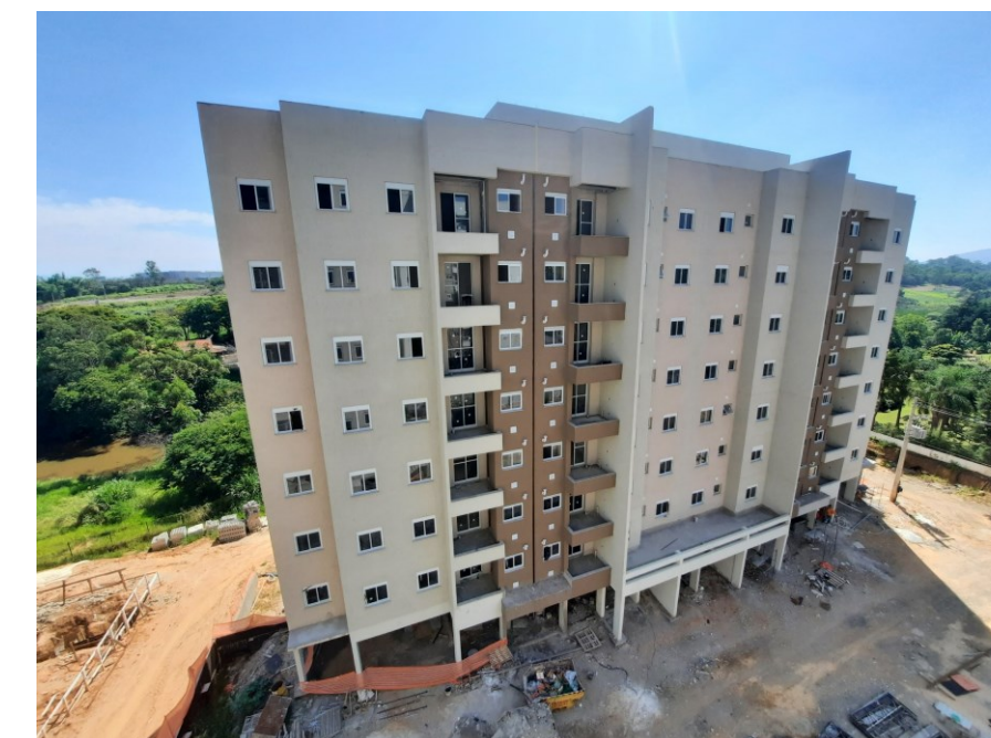
Torre 5 - Yes Jundiaí - Medição de obra Monitori 12/23 (89,62%)
