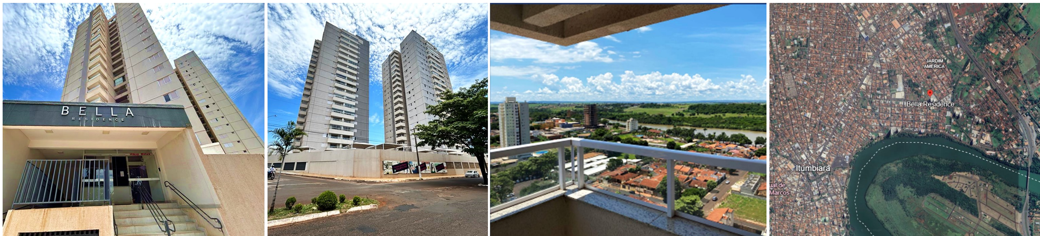
Empreendimento Bella Residence – Visita Técnica DOMI
